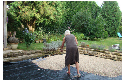
Afb. 24.2-24 Het grind verdelen
