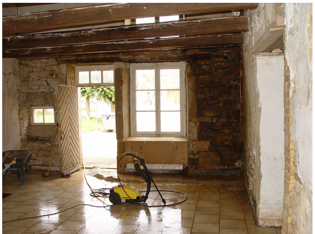
Afb. 24.2-12 Afspuiten van de buitenmuur. Deze is nu nog nat. De gedroogde en gevoegde muur ziet u op afb.15
