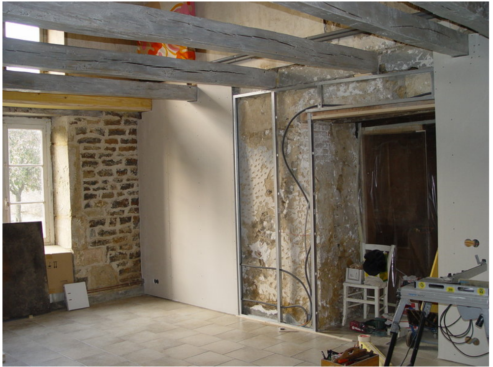
Afb. 24.2-15 Begin van de beplating
