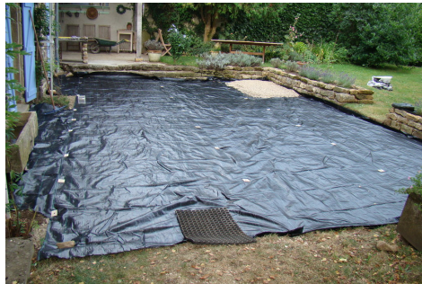
Afb. 24.2-23 Het tout venant is met géotextile afgedekt, het eerste grind ligt erop (rechts achter)
