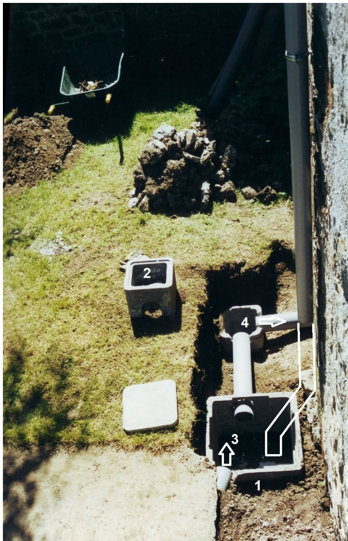
Afb. 24.2-7 Installatie van de nieuwe regenwater afvoerput. 1 = de put, 2 = opzetelement voor putje 4, 3 = regenwaterafvoer van de auvent, 4: afvoer naar het riool - de afvoerbuys ligt hier nog provisoirisch, die krijgt natuurlijk een afschot naar rechts!
