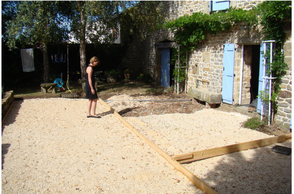
Afb. 24.2-22 Het eerste vak is gevuld en afgereid, nu het tweede.
