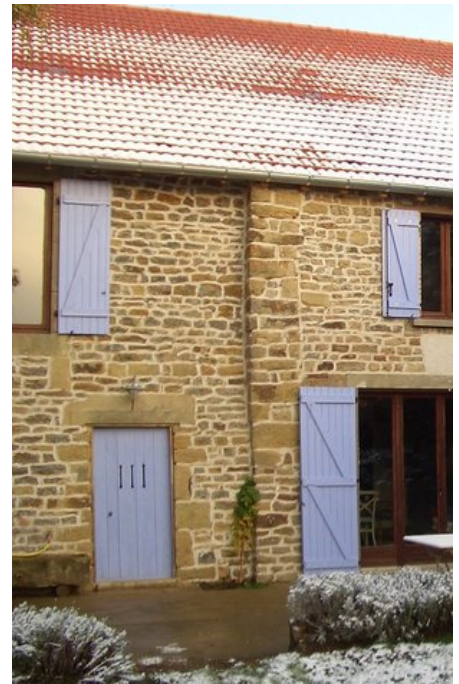
Afb. 24.2-11 De nieuwe dakgoot, bij de eerste sneeuw in november 2003
