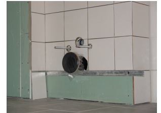
afb. 24.1 - 23 Dan het profiel voor de tweede rij plaatsen en deze tegelen
