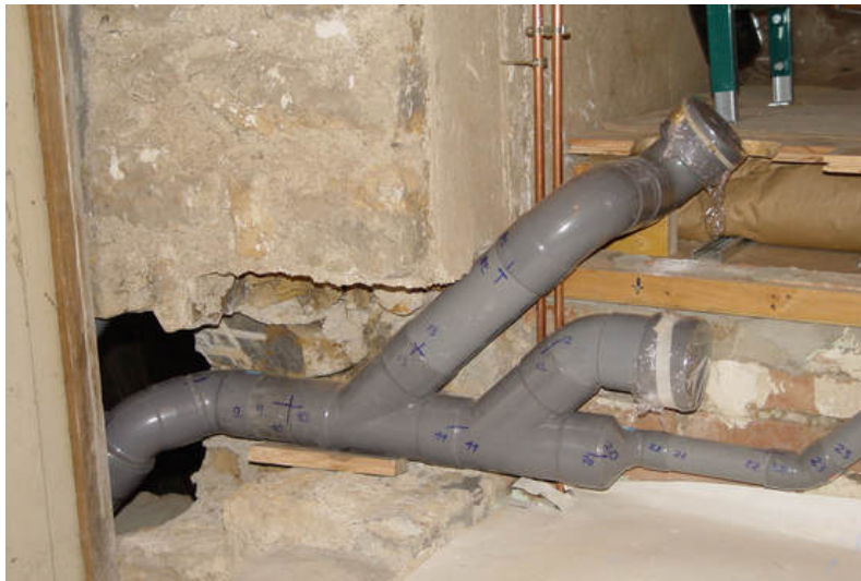
Afb.24.1-7 Rioleringsbuizen 'koud' in elkaar gezet en ondersteund, alle stukken van passtrepen voorzien en genummerd
