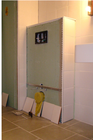
afb. 24.1 - 21 Een metaalprofiel aanbrengen
