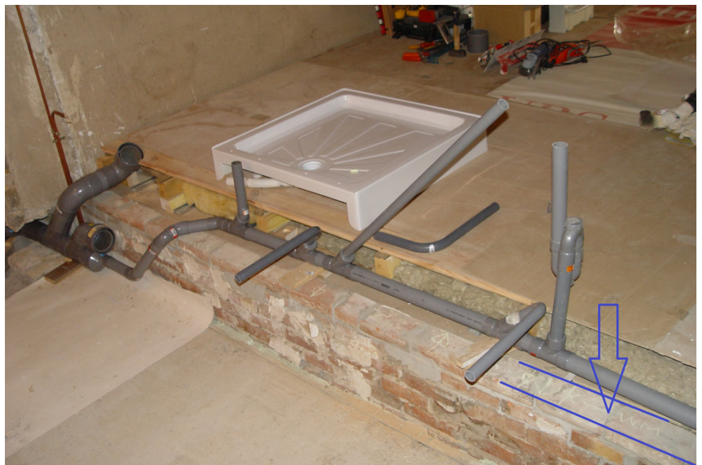
Afb.24.1-6 De rioleringen provisorisch gelegd. Vlnr: WC gastenbad, WC badkamer, douchebak gastenbad, wastafel 1, wastafel gastenbadk., wastafel 2, sifon voor wasmachine (die dan niet geplaatst werd)
