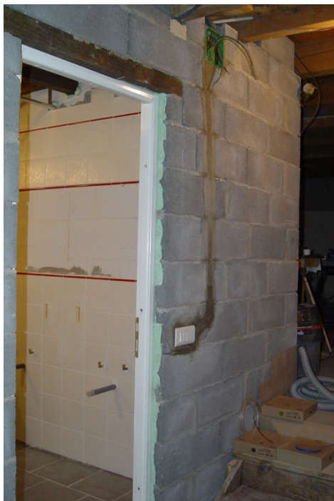
Afb. 24.1-28 Leidingsaanleg aan de buitenkant
