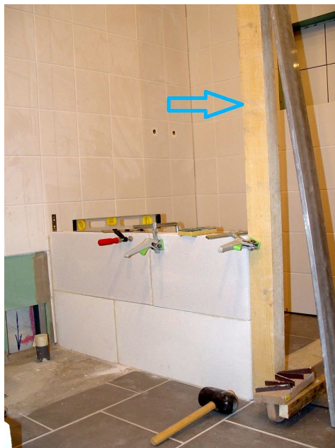
Afb. 24.1-15 Opbouw van de doucheafscheiding. Rechts een balk als mal.
