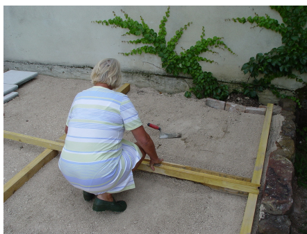
afb. 19.2 - 10 Ook hier weer waterpas afreien
