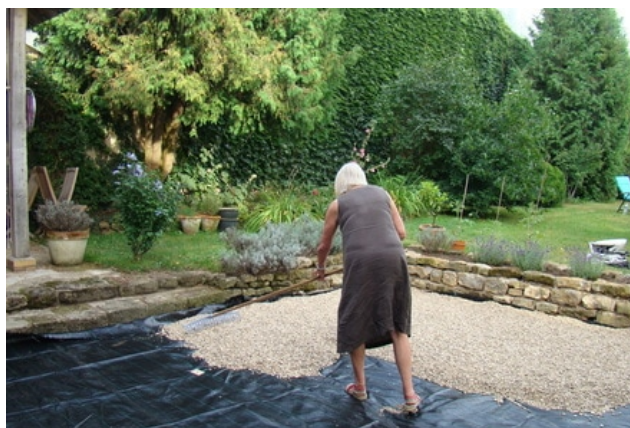
afb. 19.2 - 8 Het mooie grind wordt in een laag van ca.5cm aangebracht
