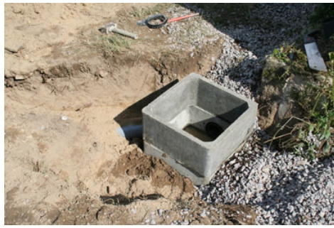
afb. 17.2 - 16 Opvullen met grind
