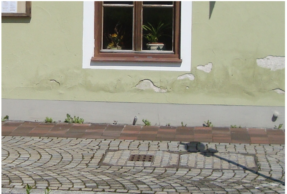
afb. 17.2 - 2 Plint met cementlaag
