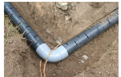
afb. 17.2 - 14 Drainagebuizen leggen
