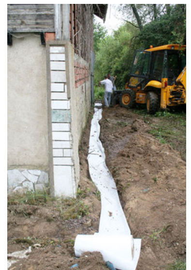
afb. 17.2 - 15 Buis en grove vulling in géotextile inpakken
