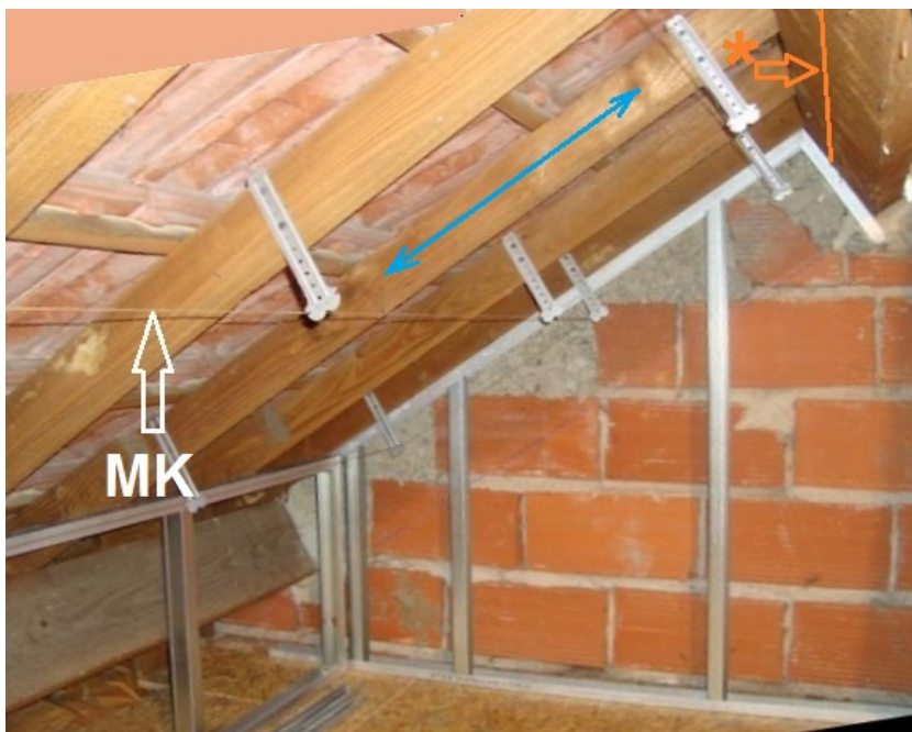
afb.15.5.3 - 7 Plaatsing van de ophangijzers bij een stevige sporenconstructie. Let op het metselkoord MK.
