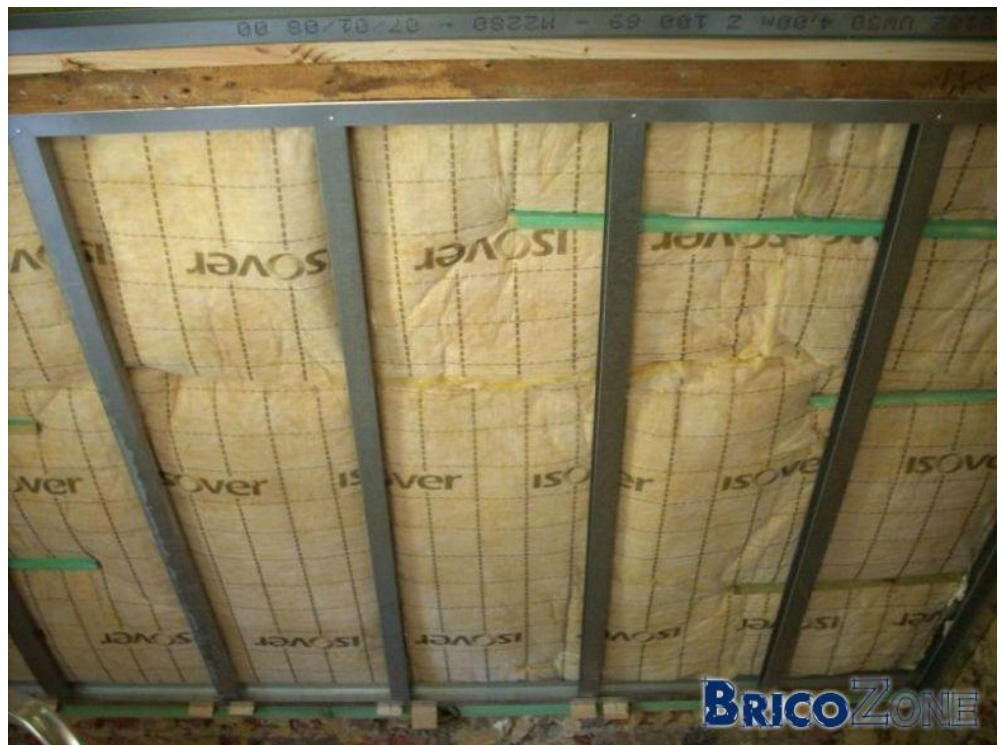
afb.15.5.3 - 11 Afwerking met wandprofielen
