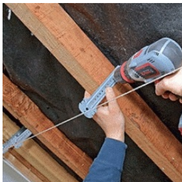
afb.15.5.3 - 8 Suspentes aanschroeven
