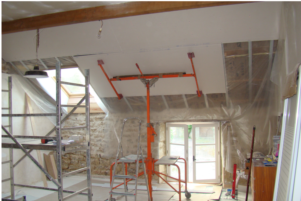
afb.15.5.3 - 6 Het plaatsen van de gipskartonplaten met een platenlift
