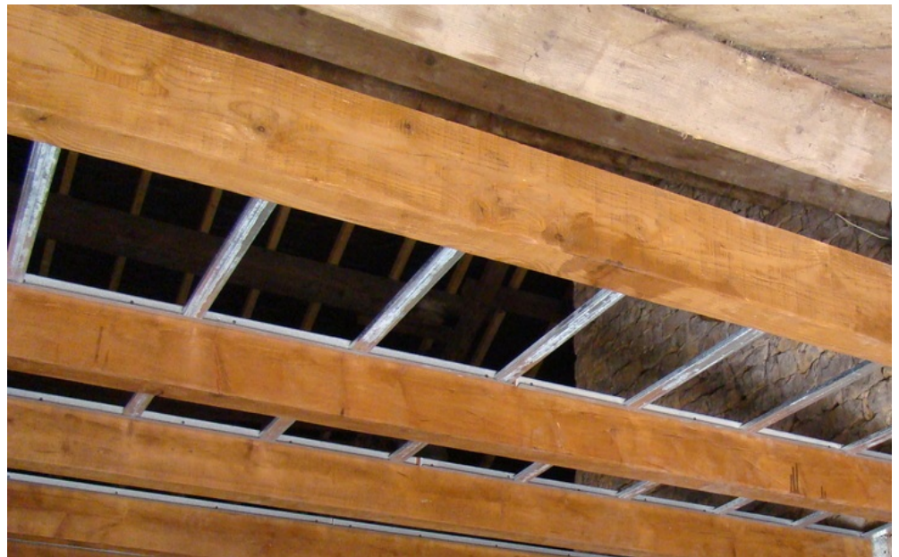
afb.15.5.1 - 6 L-profielen aan bovenkant balk
