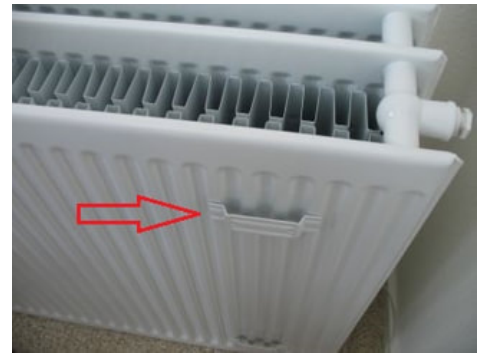
afb. 12.1.3 - 18 Radiator met ophanglussen, hier een model 33, dus drie platen plus drie convectieelementen
