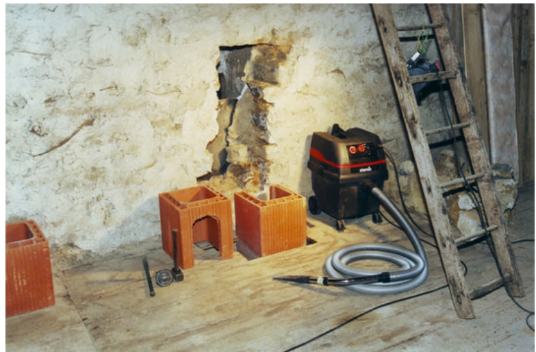
afb. 12.1.3 - 4a Hier komt de schoorsteen en boisseaux door het plafond en is de toegang naar de achter de muur liggende schoorsteen opengemaakt
