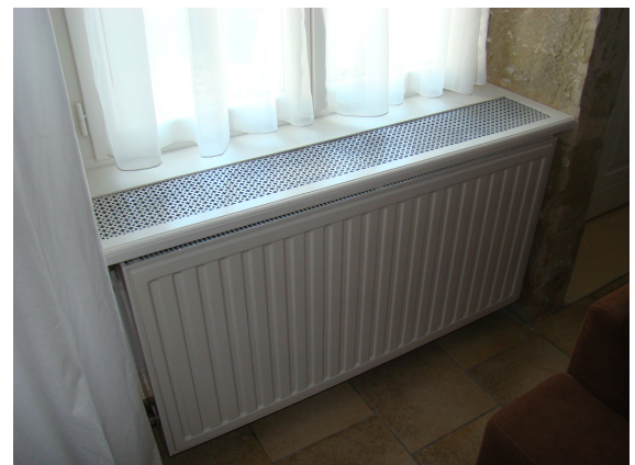
afb. 12.1.3 - 7b Rooster in vensterbank, hier bij een 'dikke' 32-radiator (3 platen, 2 ribelementen)
