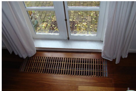
afb. 12.1.3 - 10 Putconvector met standaard houten rooster
