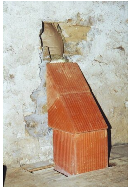
afb. 12.1.3 - 4c De aansluiting wordt met op maat geslepen boisseaux afgedekt, de rest van de opening wordt dichtgemetseld
