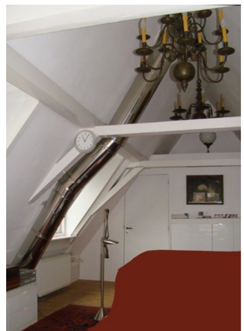
afb. 12.1.3 - 2 Dubbelwandige RVS pijp
