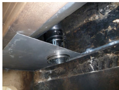
afb. 12.1.2 -14 Afsluitplaat in openhaard, hier tijdens de installatie.
