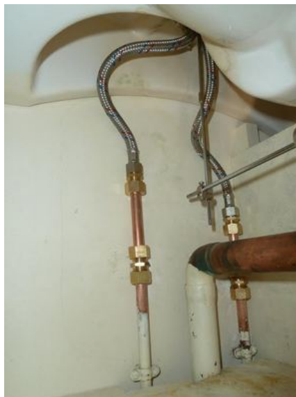
afb. 10.1.7 - 1 Linker wastafel: Beide toevoerpijpen om 10cm verlengd - alles OK!
