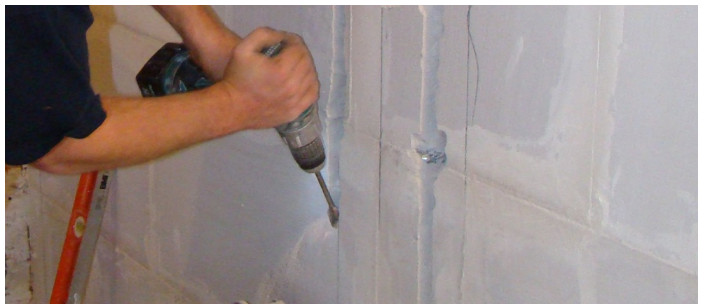
afb. 10.1.1 - 3 Inhakken van leidingen in een wand van gasbeton
