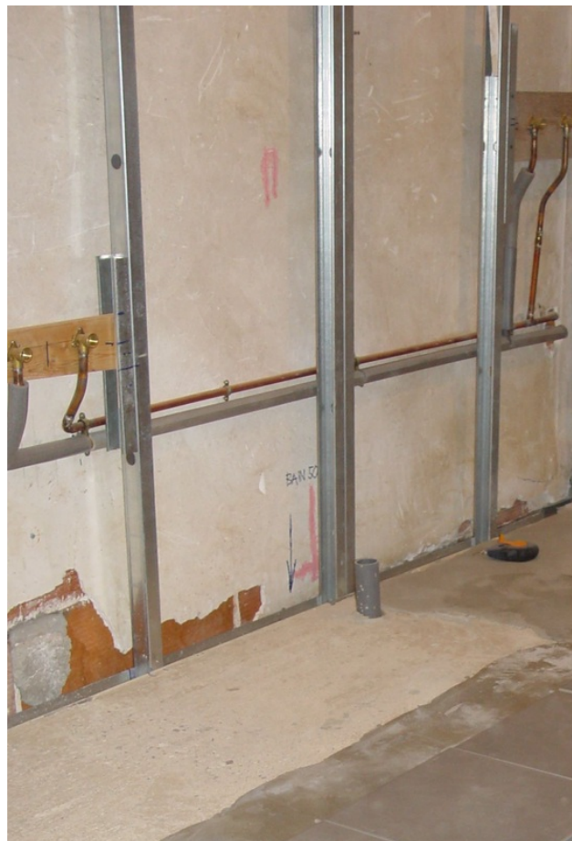
afb. 10.1.1 - 4 Leidingen achter de ossature van een voorzetwand van gipsplaat
