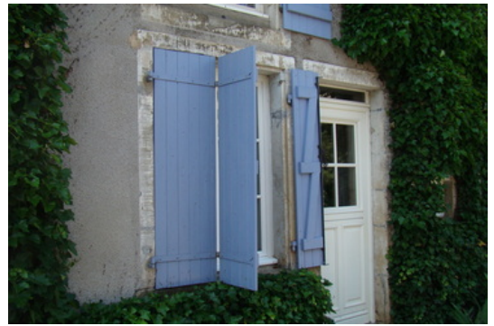
afb. 09.4.5 - 13 Een dubbelvouwend luik (links) plus een smalle vleugel (rechts) -> double-folding shutter (left) and a smaller one (right)
