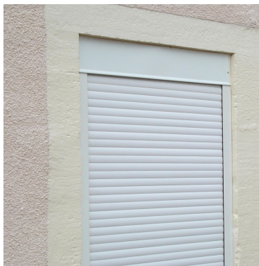
afb. 09.4.2 - 3 Rolliuk met binnenliggende rolkoker
