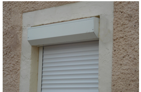
afb. 09.4.2 - 4 Rolliuk, hier bij een deur, met buitenliggende rolkoker. Ja, voor de koker van dit 2,2m lange rolluik was de nis niet diep genoeg.
