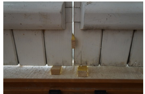
afb. 09.4.1 - 5 luiken afstellen met wiggen - van binnen gezien (dit is een ander project)
