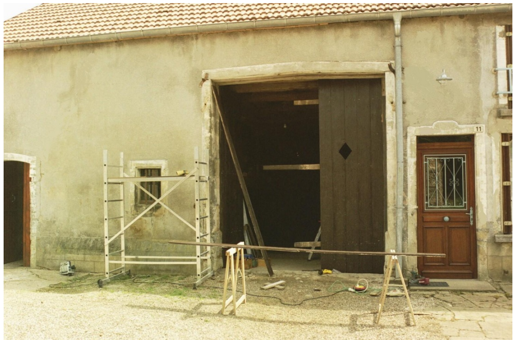
afb. 09.3 - 12 De renovatie van een van onze schuurdeuren. -&gt; The renovation of our barn door.
