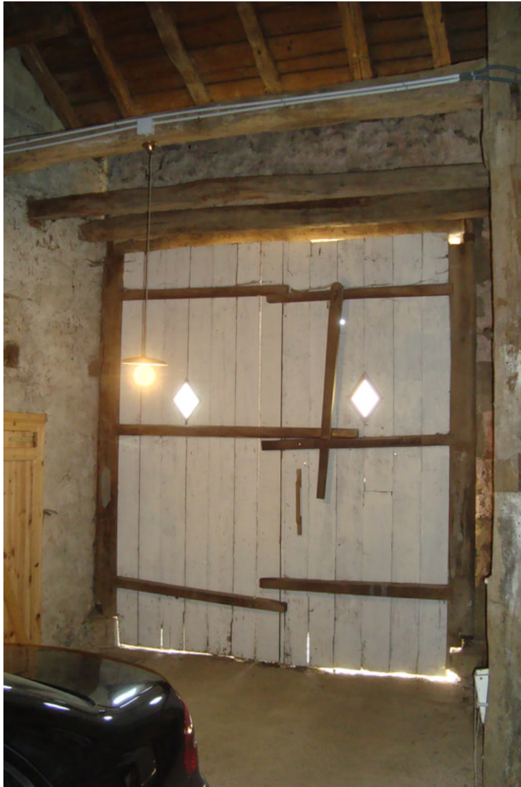
afb. 09.3 - 14 schuurdeur van binnen -> inside view of the barn door
