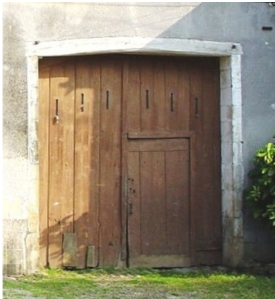
afb. 09.3 - 22 De oude schuurdeur
