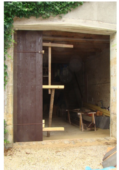
abb. 09.3 - 26 Beplanken van de gerepareerde ossature
