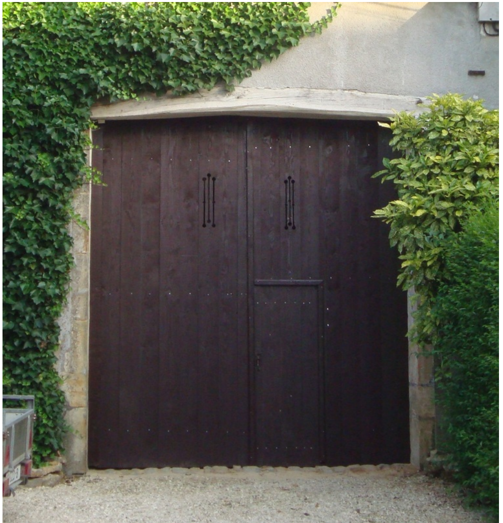
afb. 09.3 - 29 De nieuwe schuurdeur, weer met loopdeur.
