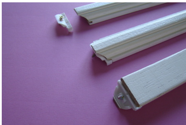
afb. 9.2.3 - 1 Inklikroedes (petits bois à cliquer). Boven: clip en roede, midden: roede ingeclipt, onder: van de andere kant gezien. -> Wooden window bars with clips, in France: petits bois à cliquer. Top: the bar and the clip, center: bar in the clips, below: same from the other side.
