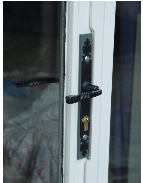
afb. 09.1.2 - 4 Nog een opdikking met staalplaat, buitenzijde, ook van binnen geschroefd.
