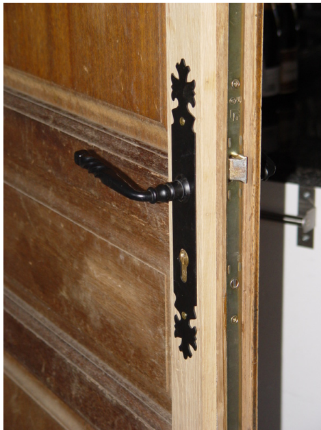
afb. 09.1.2 - 3 Deur door een hardhouten plank opgedikt om het slot volledig in de deur te laten verdwijnen.
