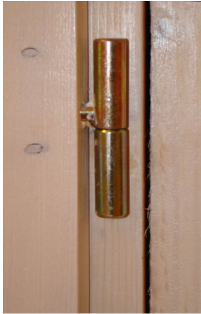
afb. 09.1.2 - 9a schroefpaumelle, gemonteerd
