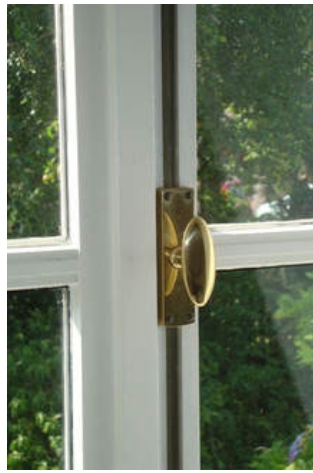
afb. 9.1.2 - 15 Crémone met draaigreep, moderne vorm, gepolijst messing
