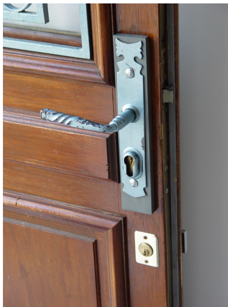
afb. 09.1.2 - 1 Voordeurslot beveiligd door een op maat gemaakte afdekplaat (grijs). De oorspronkelijke afdekplaat is met slotbouten vastgezet. Daaronder een bijzetslot dat volledig in de deur verzonken is.
