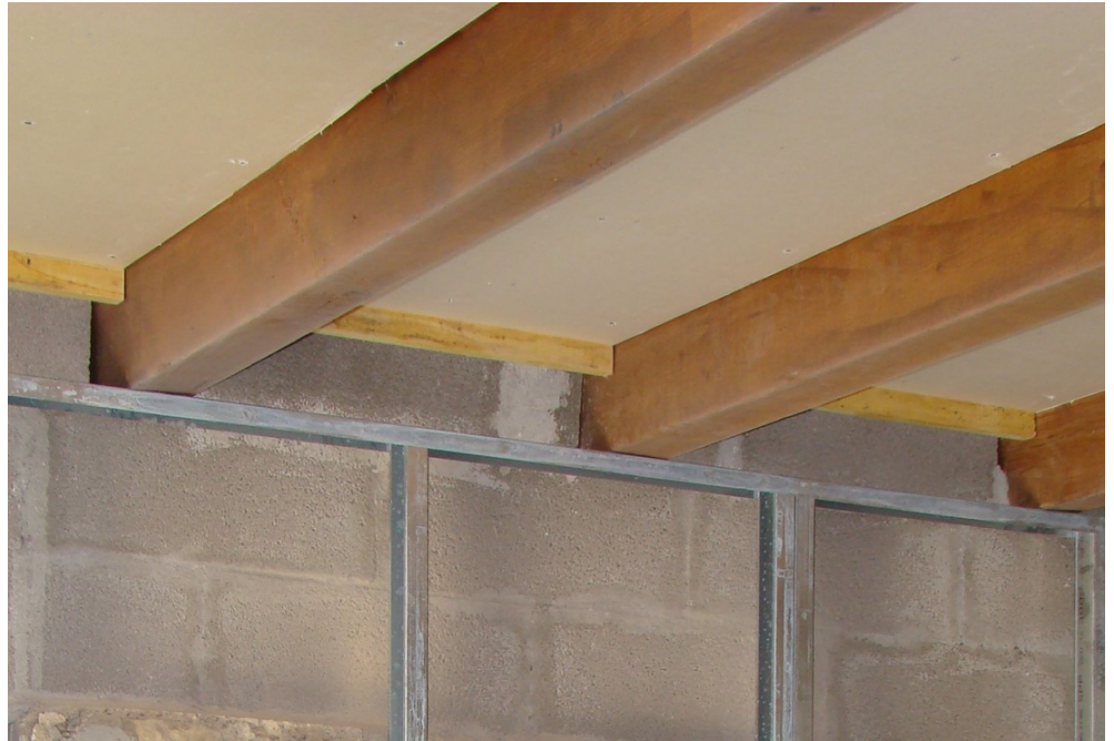
afb. 08.4 - 4 Eerst plafond, dan de wanden
