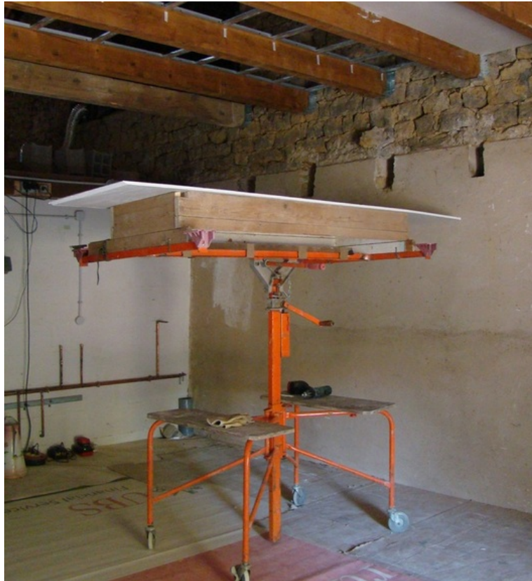
afb.08.3 - 17 Lève-plaques met opbouwframe -> the board lift, here with an auxiliar frame on it
