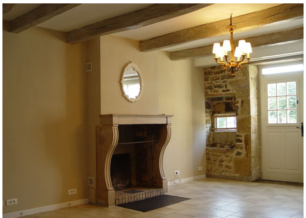
afb.08.3.4 - 4 In deze ruimte liggen de gipsplaten op de balken. -> plasterboard laid on the beams
