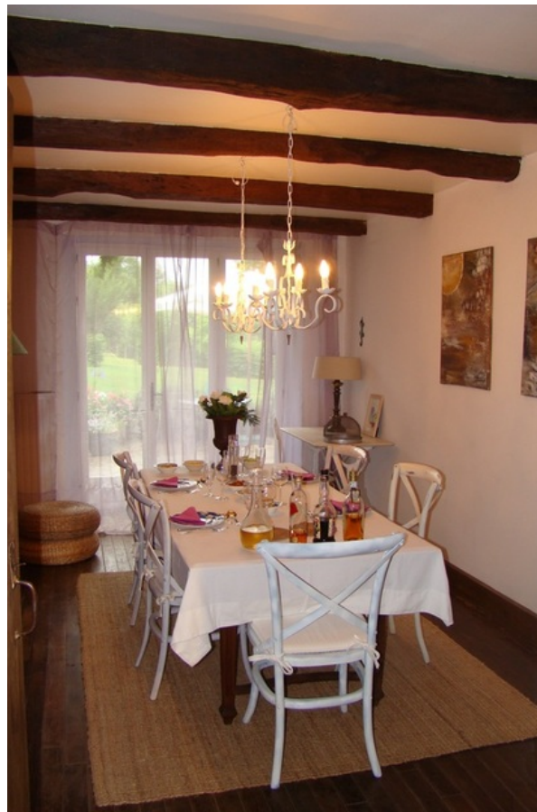
afb.08.3.4 - 1 Gipsplaten tussen onregelmatige balken -> nice ceiling between irregular beams
