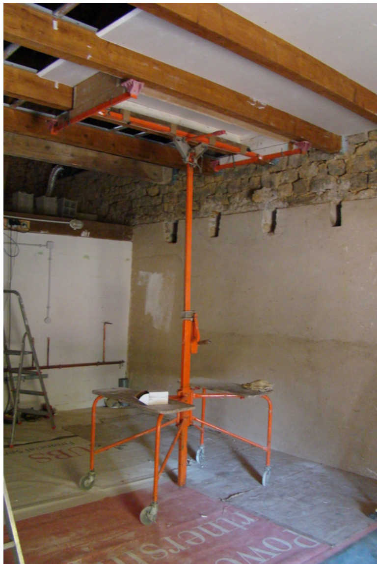
afb.08.3 - 18 Plaat tussen de balken geplaatst, klaar voor het vastschroeven -> board lifted between the beams, ready to be fixed with screws
