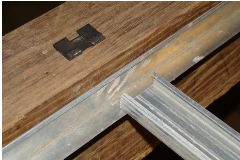
afb.08.3.4 - 5 L-profiel, plafondrail ingelegd, clip nog niet geplaatst -> L-profile against beam, supporting profile placed but not yet clamped
