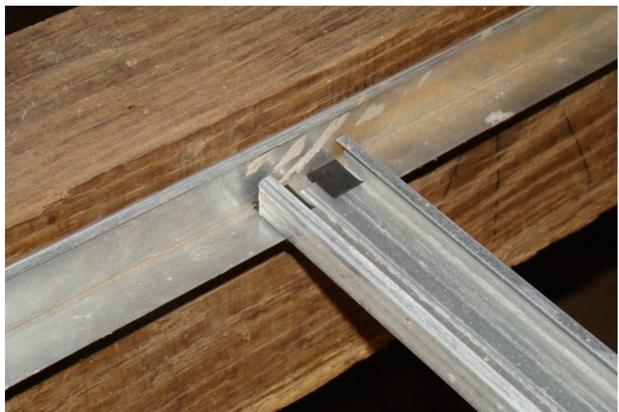
afb.08.3.4 - 7 clip geplaatst -> clip has been placed
