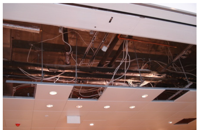
afb.08.3 - 5 Hangend gipsplaten-systeemplafond
