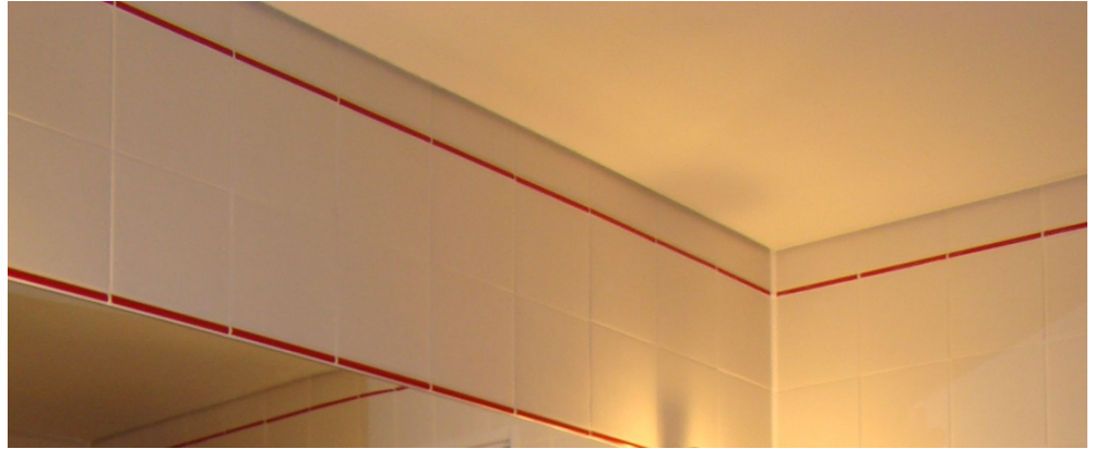
afb.08.3.2 - 18 Zwevend plafond in mijn badkamer, met T-profiel gerealiseerd
