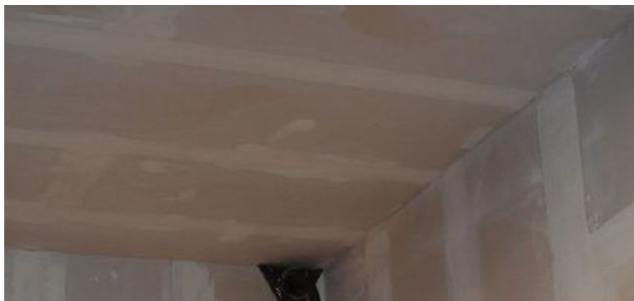
afb. 08.3 - 4 Hangend gipsplatenplafond, naden afgewerkt, nog niet geschilderd
