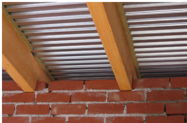
afb. 08.2.3 - 5 Geluidsdempende laag tussen balk en plaat
