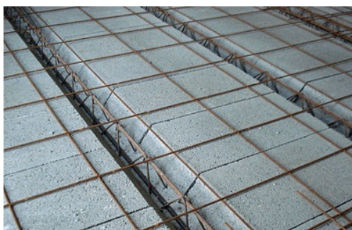
Afb. 8.2.2 - 6 Bouwstaalmat op de liggers -&gt; welded steel reinforcement net layed on the beam's reinforcement
