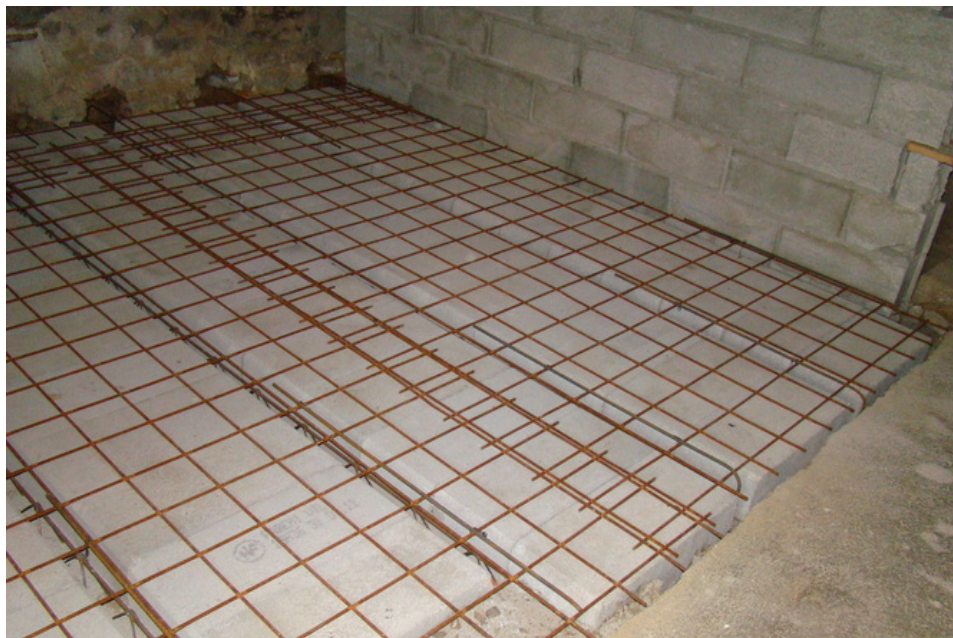
Afb. 8.2.2 - 8 Gereed voor het beton storten -&gt; ready for casting the concrete
