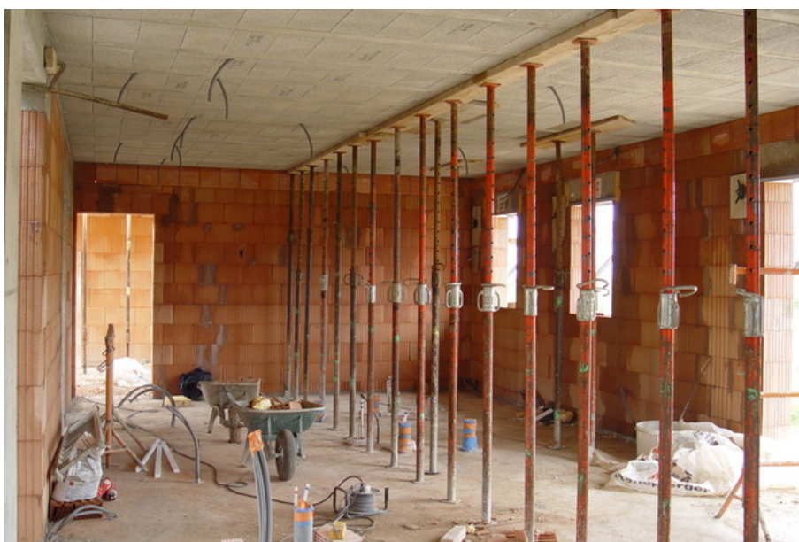
afb. 08.2.2 - 13 Vloer ondersteund met schroefstempels. -&gt; floor supported by acrow props.
