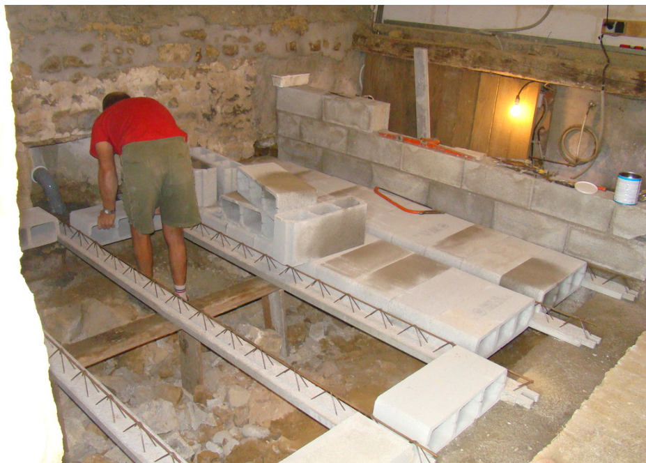
Afb. 8.2.2 - 5 Nog even de afstand van de poutres controleren voor men alle blokjes plaatst. -&gt; Check the distance between the beams before installing the next row of blocks.
