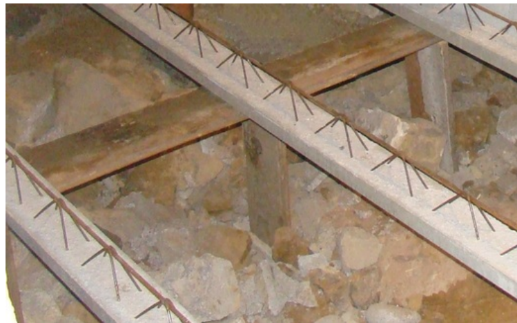
Afb. 08.2.2 - 16 Verloren ondersteuning; dit is een uitvergroot detail van afb.5 -> Lost support in a 'vide sanitaire'; detail from pic.5
