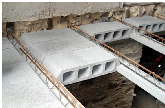
Afb. 8.2.2 - 4 De broodjes een voor een leggen -&gt; Lay the blocks one by one
