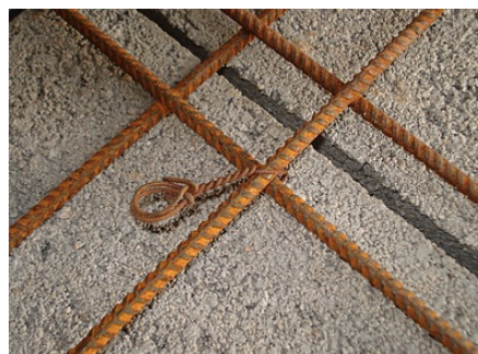
Afb. 8.2.2 - 7 Mat en staven verbinden -&gt; connect the two
