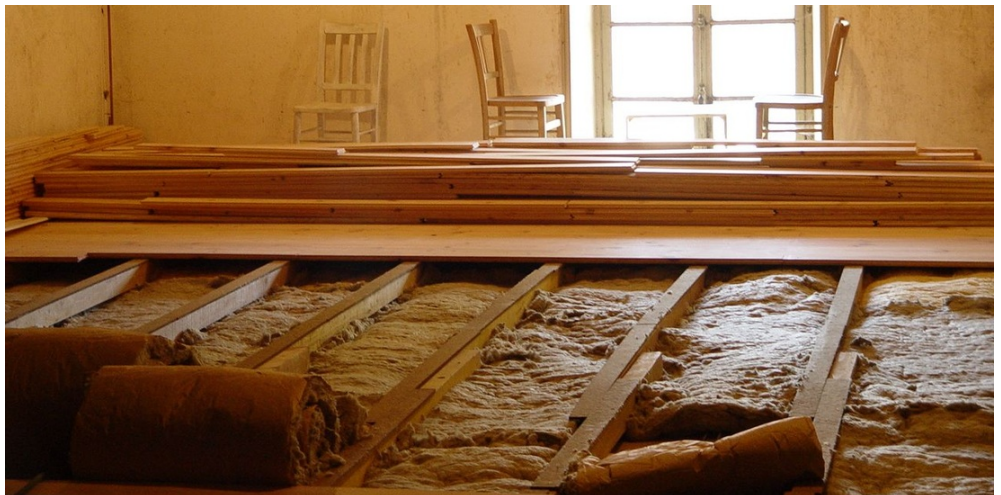
afb. 08.1.6 - 4 vloerplanken leggen op de balkjes; let op de viltrep (geluidsminderend)
