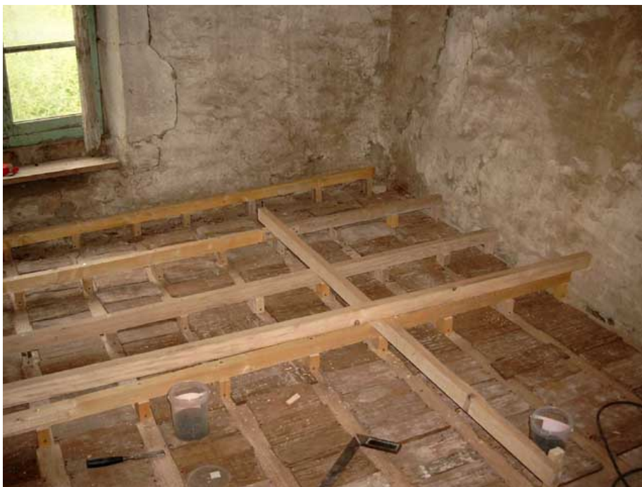
afb. 08.1.6 - 1 Opdekvloer op vloer à la Française (foto Peter Schot van wie ook de openingsfoto van dit hoofdstuk is)
