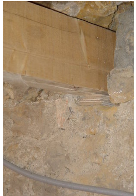
afb. 08.1.4 - 5b ruimte onder balkenkoppen met stukken tegels opvullen -> level the beam's heads with pieces of tiles
