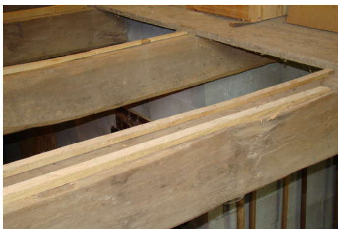
afb. 08.1.4 - 10 scheggen op balk gespijkerd, hier niet helemaal aan de buitenkant omdat de balken daar een beetje rond zijn. -> fill-up battens on a beam, the right one not flush with the beam's side since this is rounded.
