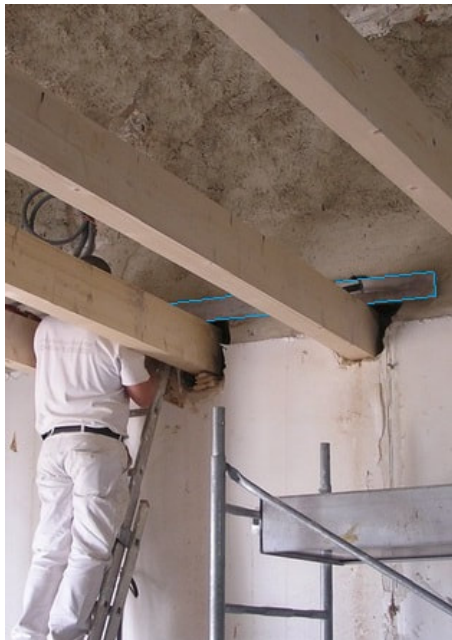
afb. 08.1.4 - 5a Waterpas op de balken (hier blauw nagetekend), opvulplaten onder de balk
