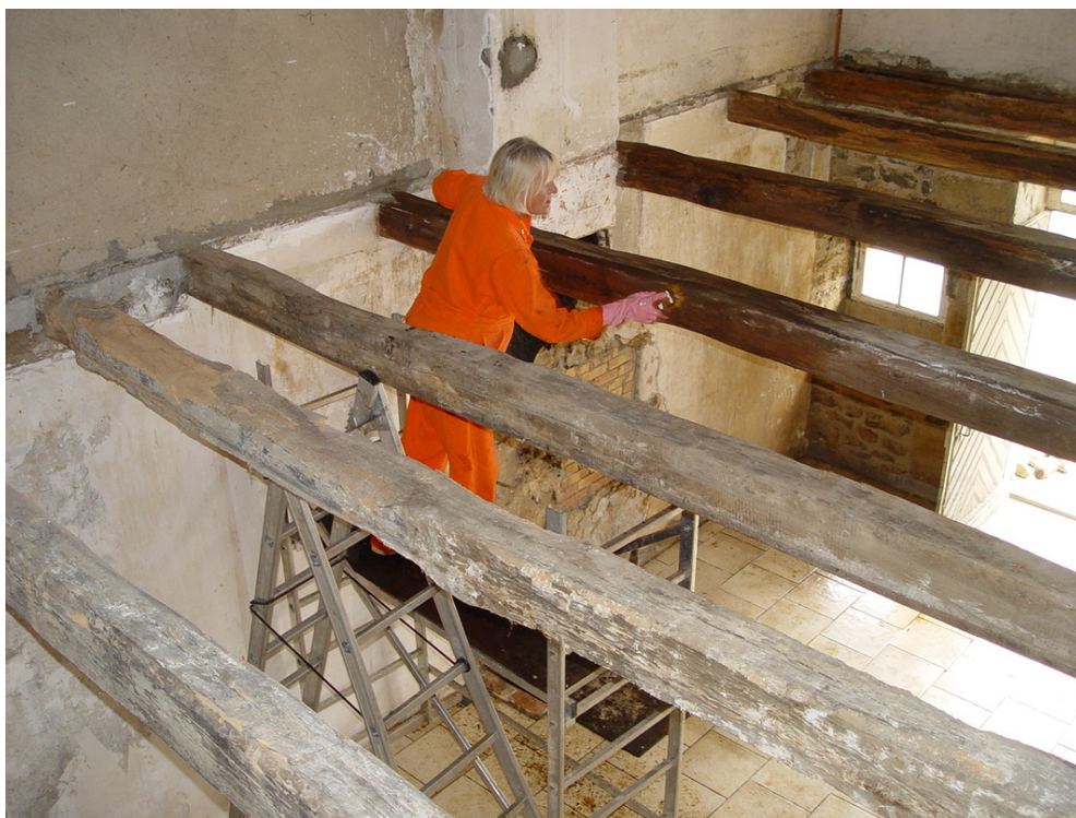
afb. 08.1.4 - 1 Kale balkenlaag, veel ruimte om te werken. Werk veilig op een ministeiger, niet op een ladder of keukentrapje! -> The bare beams, enough space to work on them. We prefer a mini scaffold to a ladder, even one with a platform.
