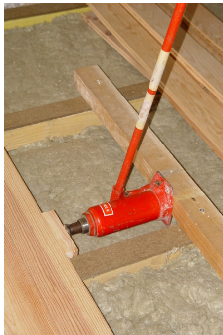
afb. 08.1.3 - 10 Planken aandrukken met een hydraulische krik
