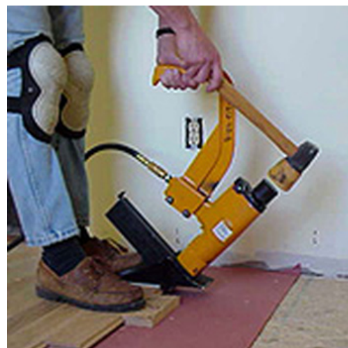
afb. 08.1.3 - 14 Floor Stapler in actie
