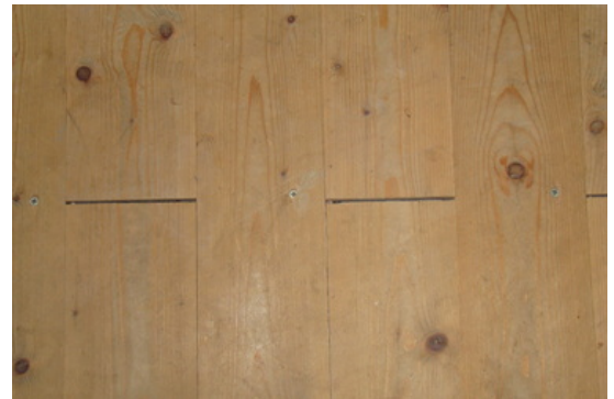
afb. 08.1.3 - 4 Lange planken --&gt; brede kieren
