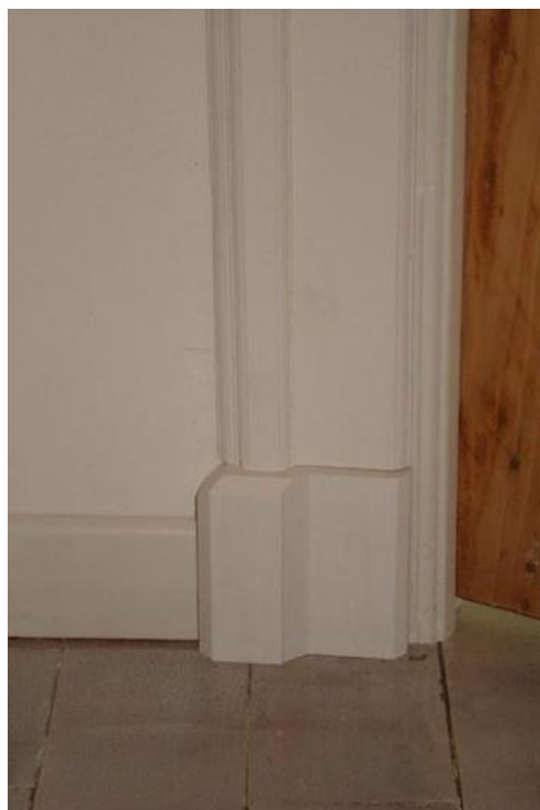
afb. 08.1.3 - 16 deurstijlbekleding, neut en plint
