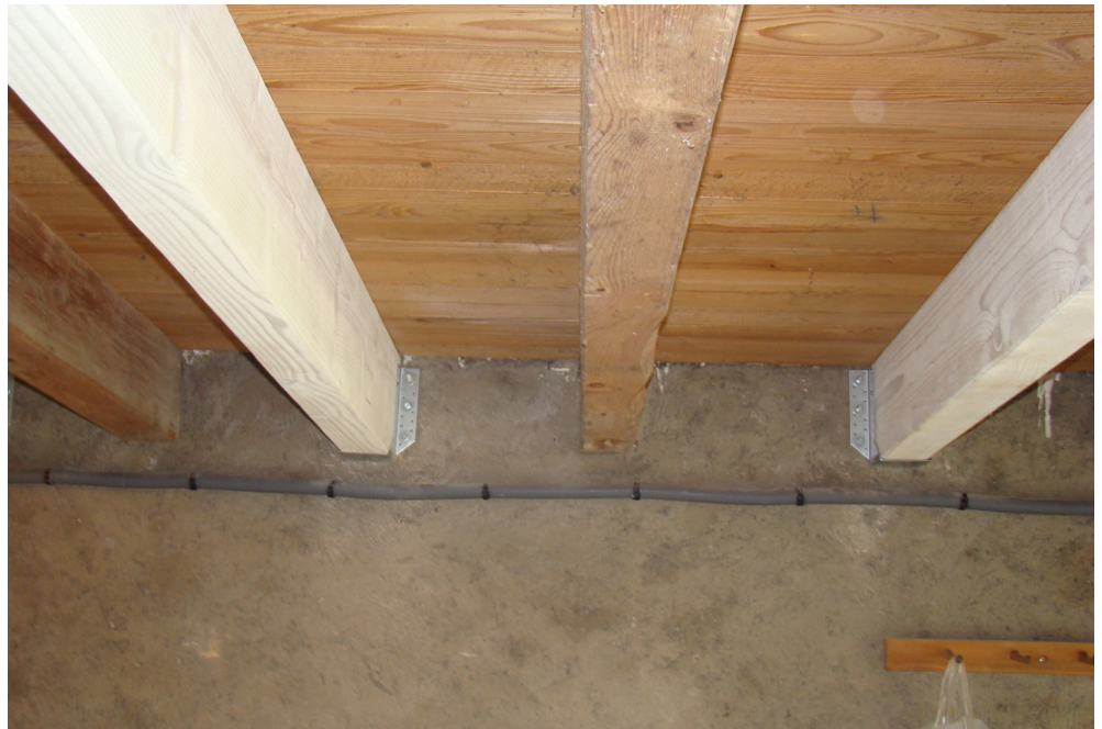
afb.08.1.2 - 9 Oude balken (kaal) en nieuwe (wit)
