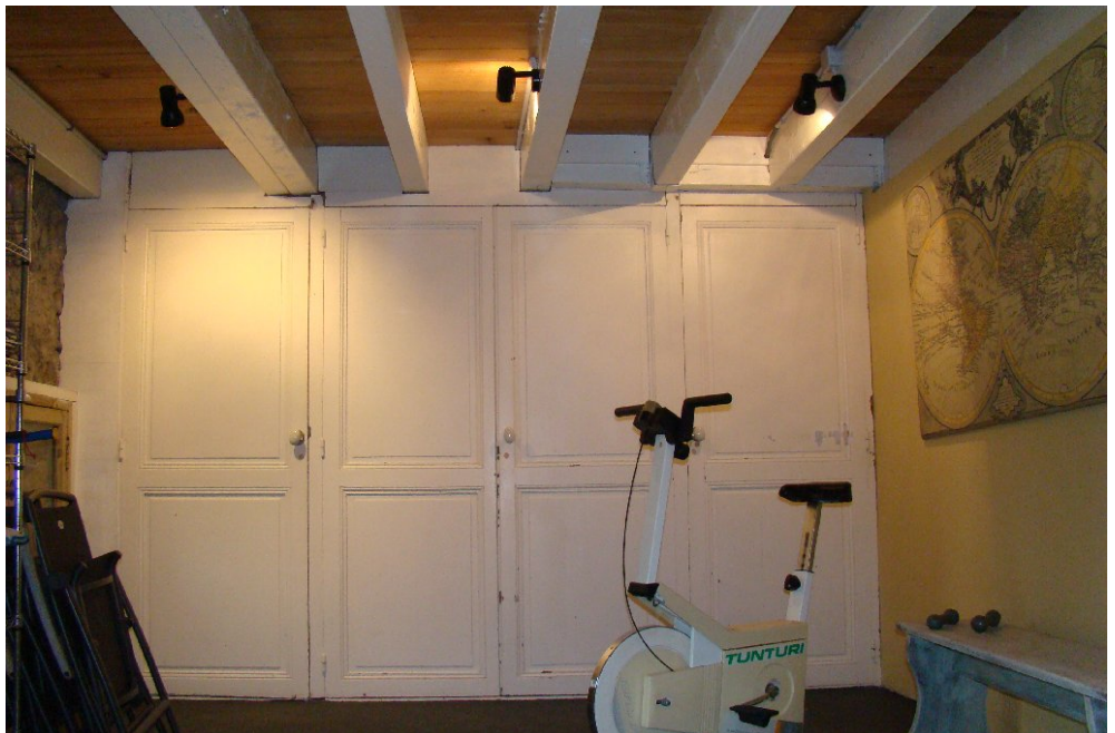
afb.08.1.2 - 13 De fitnessruimte zoals die er nu uit ziet: alle balken geverfd, planken blank gebeitsd, een gerecupereerde kastwand geplaatst, nieuwe verlichting.
