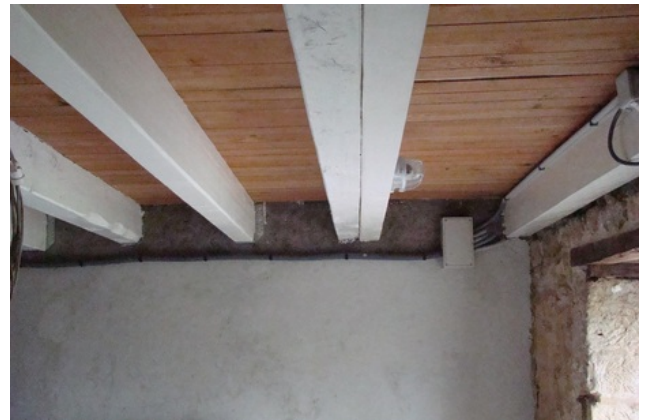
afb. 08.1.2 - 10 Sisterbalk en e-kast (opgenomen nadat ook de oude balken in de verf zaten)
