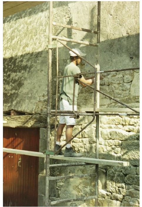
afb. 07.2 - 5 Crépi met de hand afslaan. --> Remove the old plaster with hammer and chisel.
