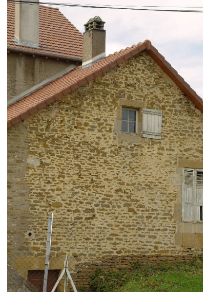
afb. 07.2 - 13 Voegen volgespoten en dan geborsteld. --> Filled with jet and then brushed.
