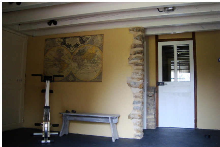
afb. 07.2 - 22 Muur met afwerkkant van natuursteen
