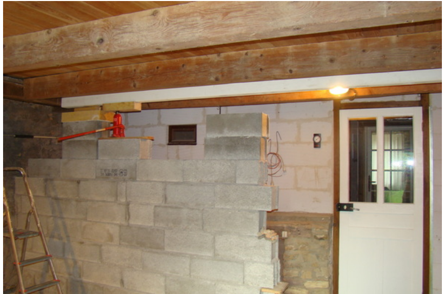
afb. 07.2 - 21 De muur van parpaings
