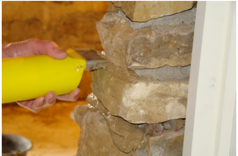
afb. 07.2 - 8b Werken met de pointmaster
