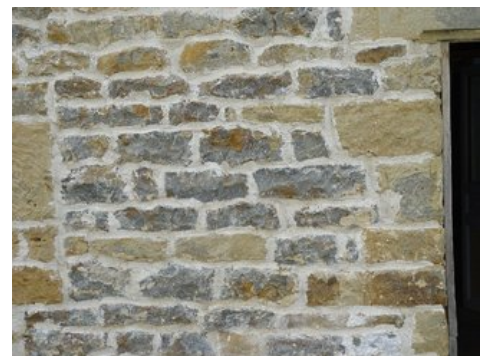
afb. 07.2 - 2 Met de hand gevoegde muur. --> The result of manual pointing.
