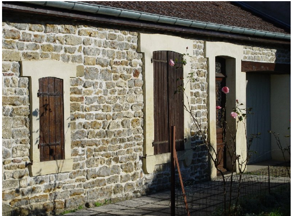
afb. 07.2 - 14 Diepliggende voegen. --> Pointing slightly recessed.
