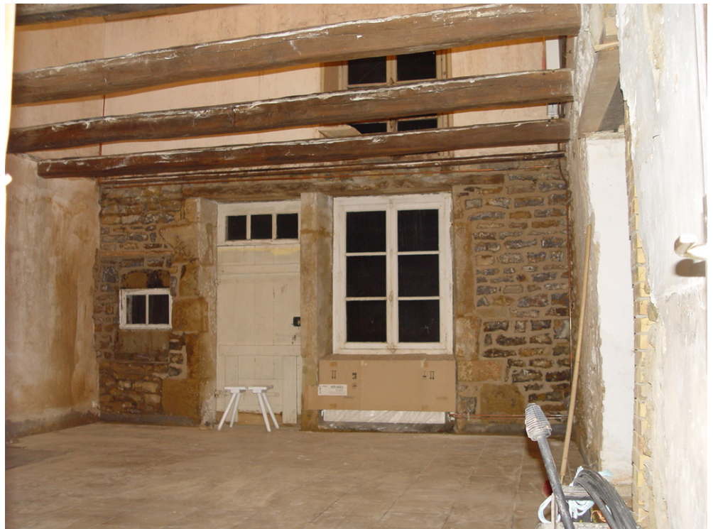
afb. 07.2 - 18 Vers gevoegd. Links rond het kleine raam zijn de voegen nog vrij vers, dus nat en donker.
