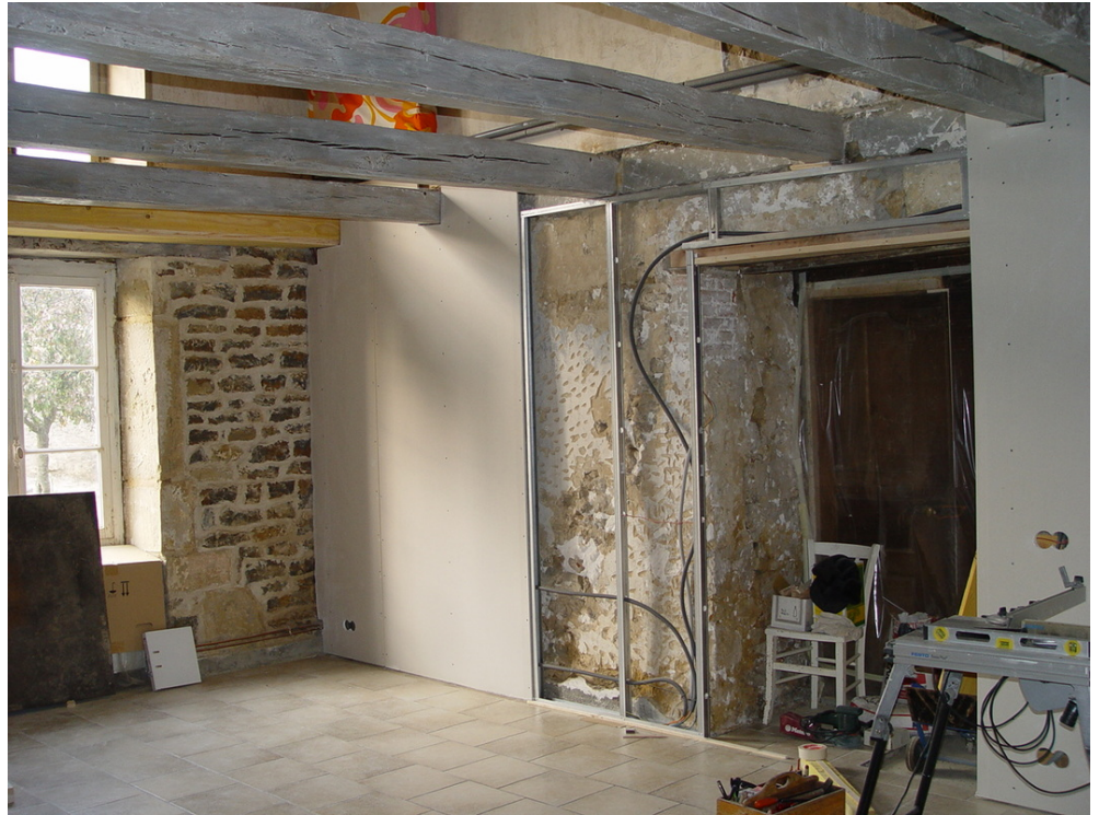
afb. 07.2 - 19 De voegen zijn droog. Gipskarton op assature wordt geplaatst.
