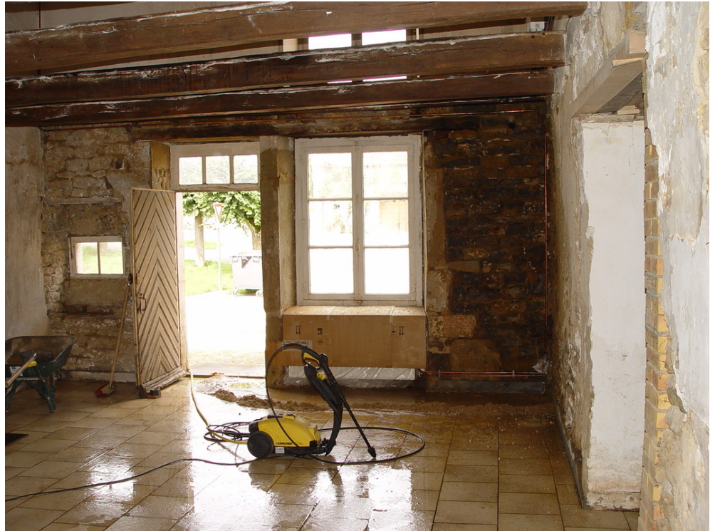
afb. 07.2 - 17 De muur is afgebikt en wordt nu schoongespoten. Let op de afvoer van het water door een dijkje naar buiten.
