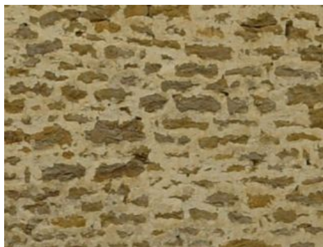
afb. 07.2 - 1 Machinaal volgespoten en dan afgeborsteld. --> Filled with a jet and then brushed.
