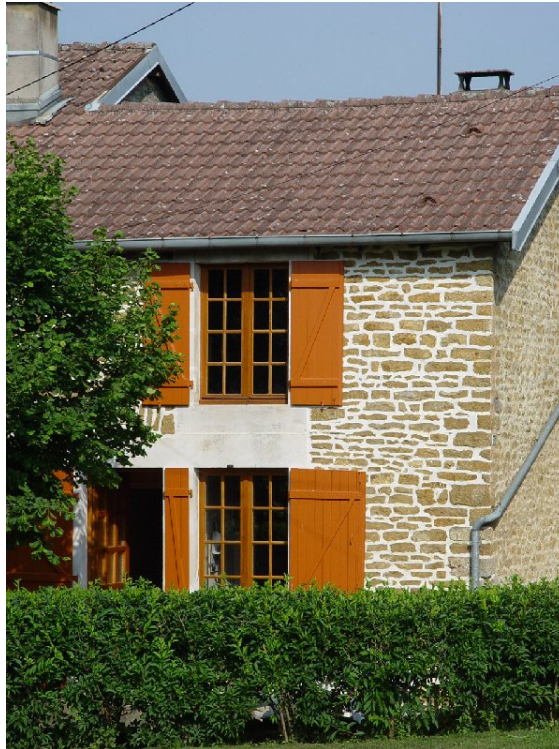
afb. 07.2 - 15 Combinatie van voegwerk en gepleisterd vlak. -> Combination of pointed stone and plasterwork.
