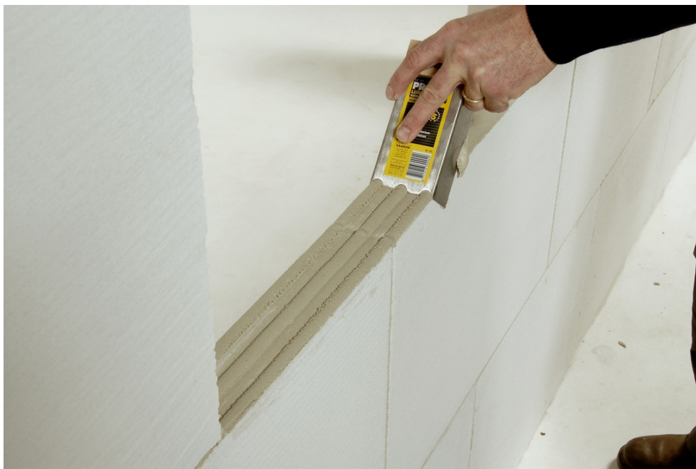
afb. 07.1.2 - 6 Lijm aanbrengen met de U-vorm troffel
