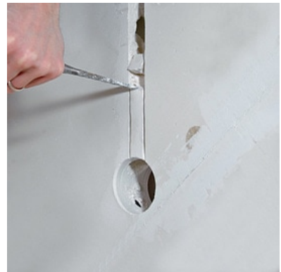
afb. 07.1.2 - 13 twee zaagsneden, dan uitbreken
