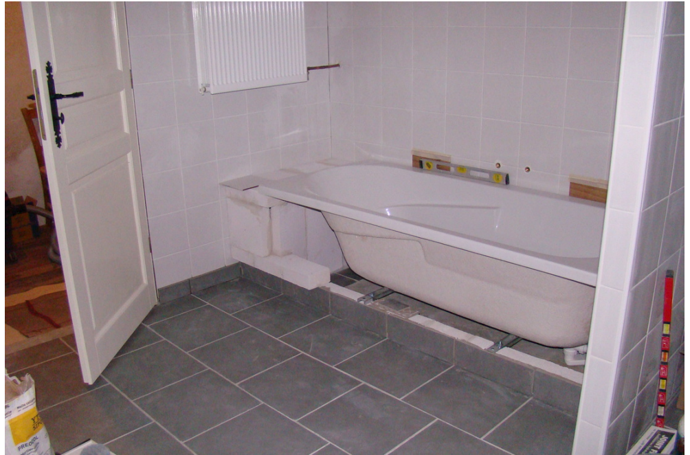
afb. 07.1.2 - 16 Badombouw van 5cm-cellenbetonblokken.
