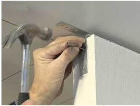
afb. 07.1.2 - 11 Plafondaansluiting met veeranker
