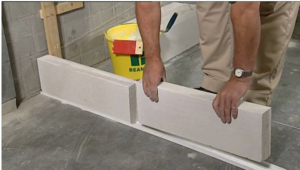
afb. 07.1.2 - 5 Het plaatsen van de eerste rij gasbetonblokken. Let op de spleet links bij de muur!
