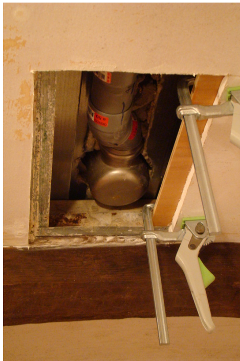
afb. 07.1.1 - 49 Multiplexstrook geklemd
