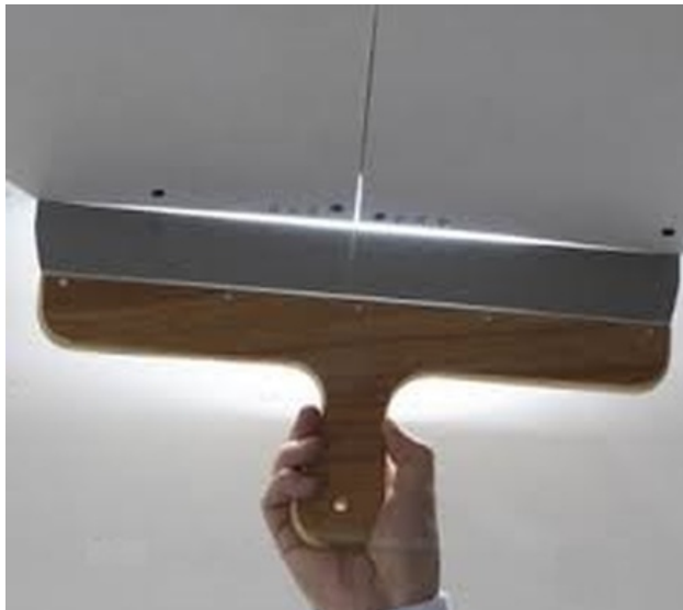
afb. 07.1.1 -32 Gebruik een breed plamuurmes! -> the tapping knife must be large enough
