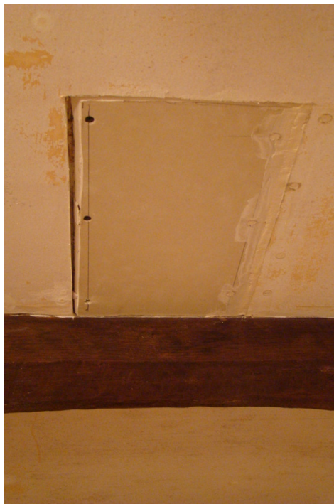
afb. 07.1.1 - 51 Reparatieplaat geplaatst, rechts afgesmeerd.
