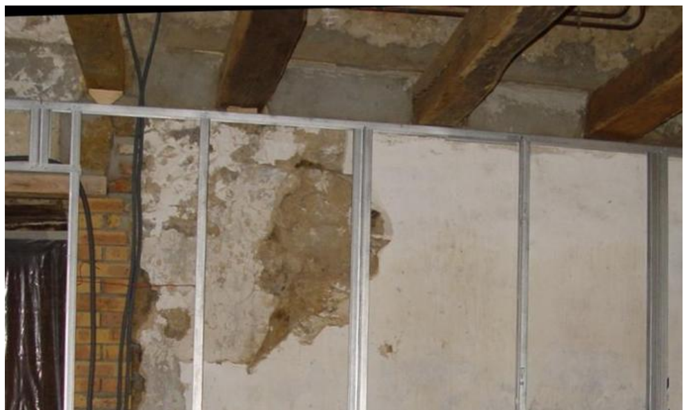
afb. 07.1.1 - 13 U-Rail tegen plafondbalken, onder de eerste en tweede balk links uitgeklost -> top partition track placed under beams with distance filling wood where necessary
