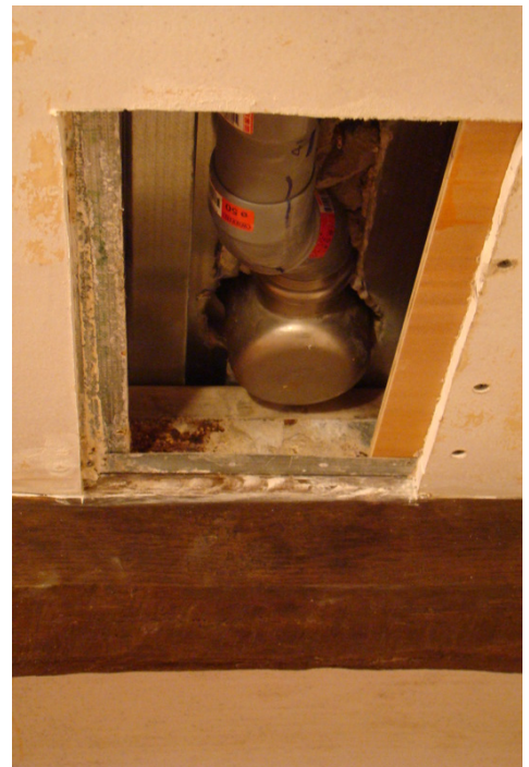
afb. 07.1.1 - 50 Multiplexstrook geschroefd
