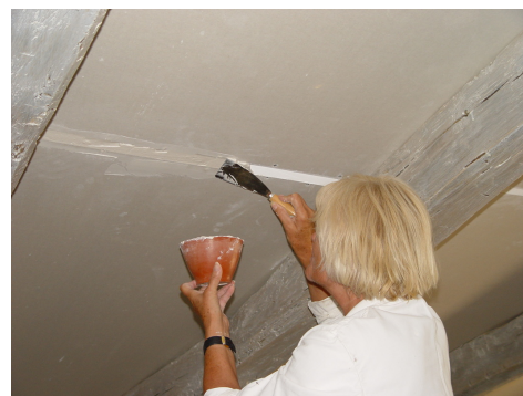
afb. 07.1.1 - 35 Naden afwerken met een breed RVS plamuurmes, beter een bredere dan hier te zien is -> filling the V-joints of a ceiling with a tapping knife (a wider one works better)
