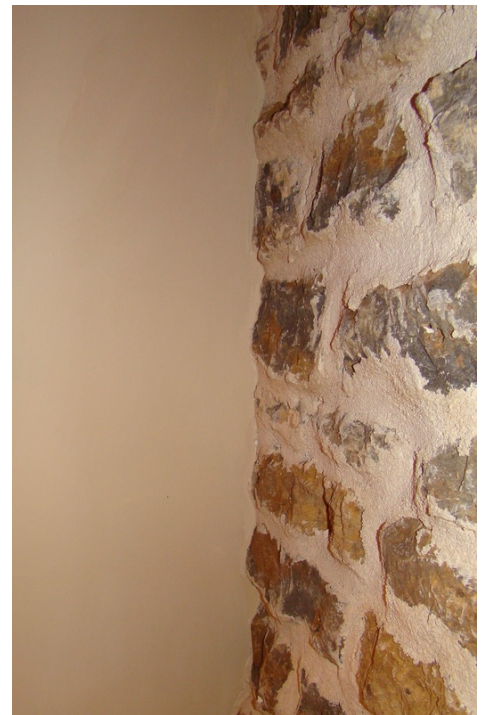
afb. 07.1.1 - 28 Uitgevoerde aansluiting van een gipskartonplaat aan een onregelmatige natuurstenen muur -&gt; plasterboard adapted to an irregular stone wall
