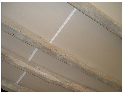
afb. 07.1.1 - 34 V-naden, nog niet gevuld -> V-joints (here in a ceiling) before filling
