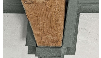
afb. 07.1.1 - 14a Profiel rondom de balk, voorgesteld door SystèmeD
