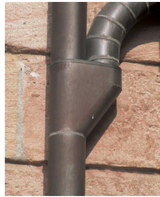
afb. 06.6 - 19 Cuvette de branchement, hier een gesoldeerd exemplaar
