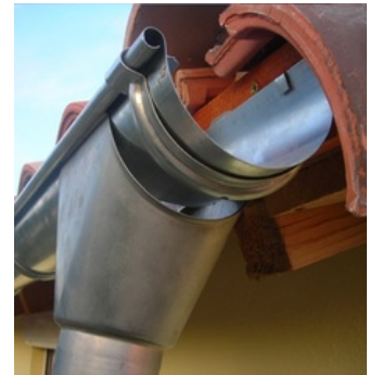
afb. 06.6 - 9b Felsrand 1 in de kraal 2, dan de lippen 3 (hier niet zichtbaar) aan de achterkant om de goot slaan
