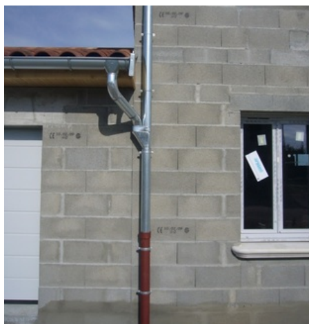
afb. 06.6 - 11 Moderne zinken valpijp met een gietijzeren dauphin
