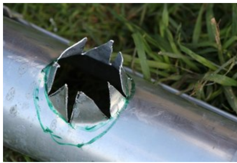
afb. 06.6 - 7 Gat voor afvoer, handmatig gemaakt
