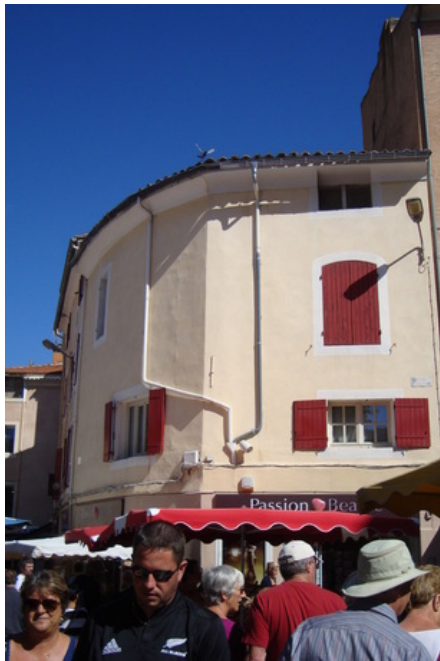
afb. 6.6 - 14 Twee valpijpen met een 'Jambon'
