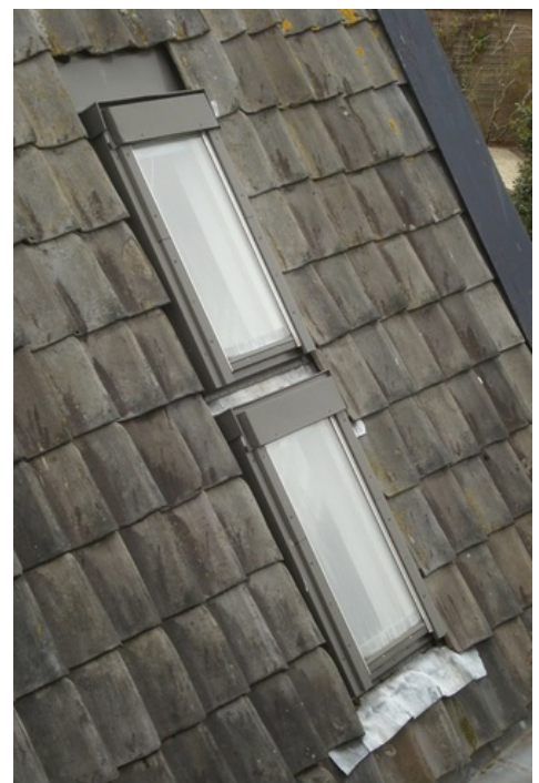
afb. 6.5.7 - 2 Twee dakramen boven elkaar, in een Noordhollands dak.
