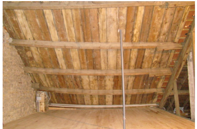
afb. 06.5.3 - 1 dak met gordingen en verticaal beschot
