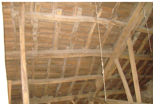
afb. 06.5.3 - 2 gordingen, sporen en horizontaal beschot
