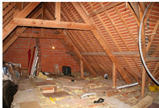
afb. 06.5.3 - 5 Compleet gerenoveerd dak.
