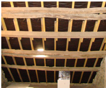
afb. 06.5.3 - 4 Gerenoveerd dak, nieuwe sporen op bestaande gordingen.
