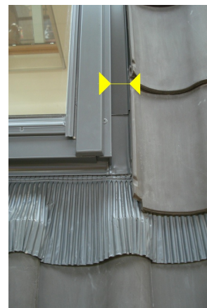
afb. 06.5.10 - 2 Deze spleet mag niet te smal zijn
