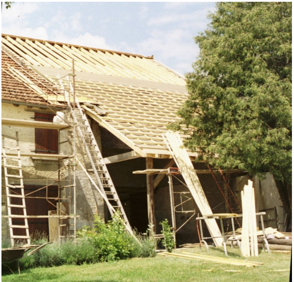
afb. 06.3 - 8 Onderdakfolie gelegd, contralatten en panlatten worden gelegd
