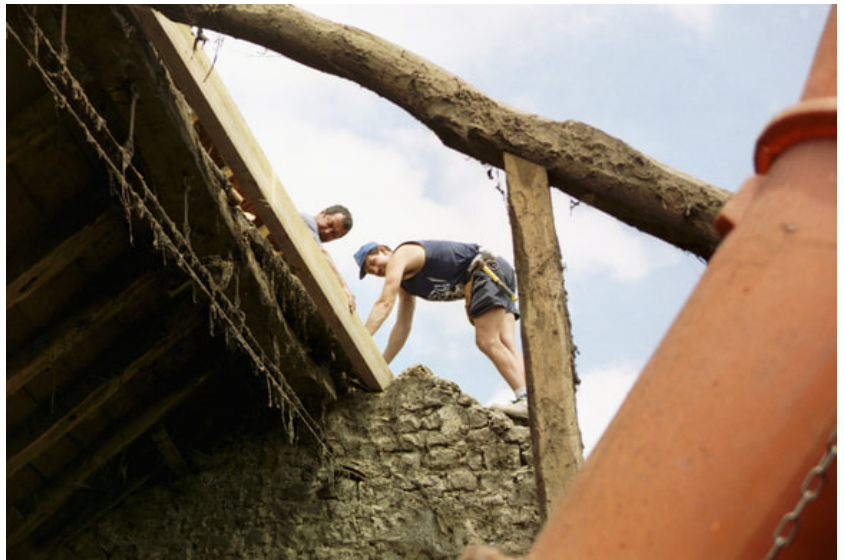
afb. 06.3 - 5 Het plaatsen van de panne faitière, de nokvorst
