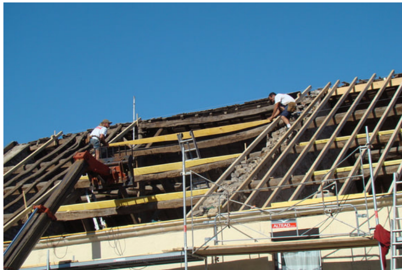
afb. 06.3 - 4 Doorgezakte gordingen (les pannes) met een aangepaste balk opvullen
