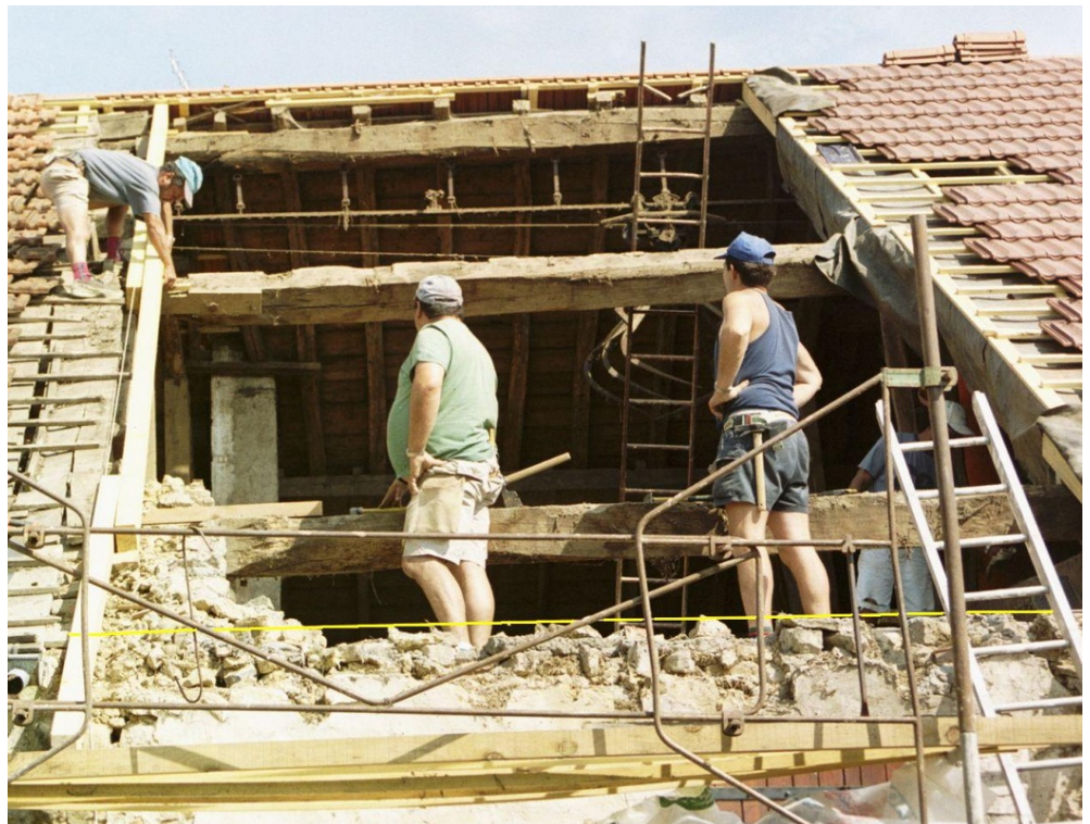
afb. 06.3 -6 Het plaatsen van nieuwe sporen (des chevrons) op de oude gordingen (les pannes), en de muur aan de voet van het dak wordt hersteld (zie het gele touwtje).
