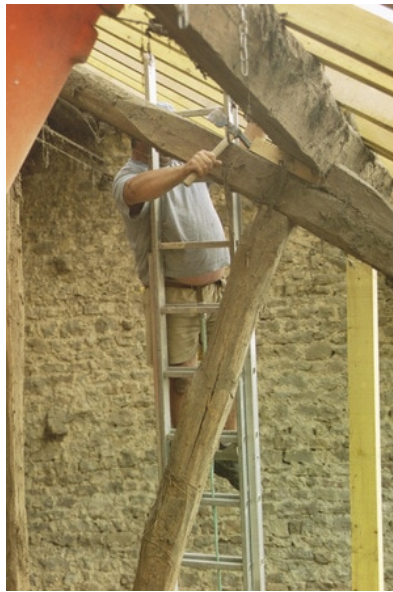
afb. 06.3 - 2 gordingen (les pannes) op de spanten uitklossen
