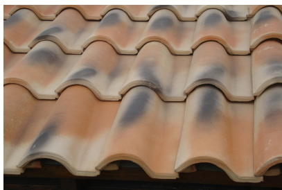
afb. 06.2.1 - 26 Dak gedekt met tuiles pseudocanal
