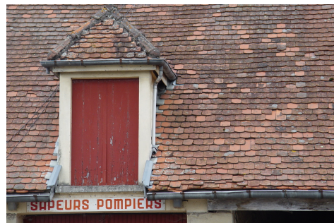
afb. 06.2.1 - 18 Zwak afgeronde tuiles plates
