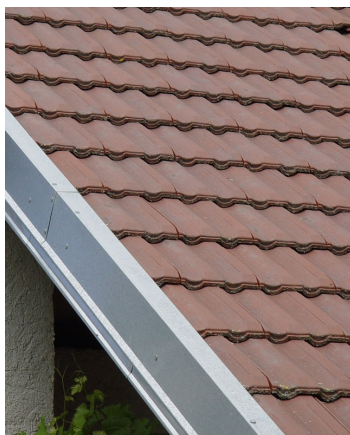
afb. 06.2.1 - 22 Dak met tuiles mécaniques
