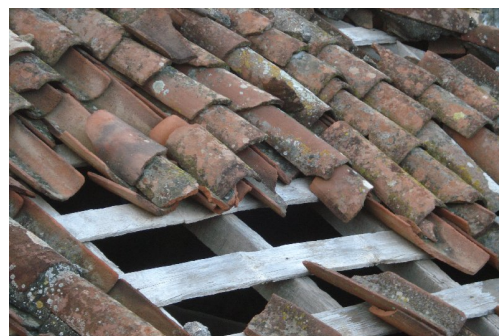
afb. 06.2.1 - 10 tuiles canal op latten
