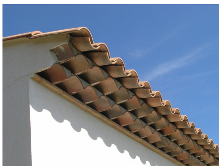
afb. 06.2.1 - 9 dakrand met twee rijen tuiles canal
