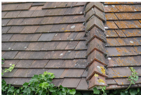
afb. 06.2.1 - 17 Tuiles plates met nokvorsten
