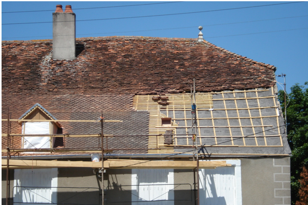
afb. 06.2.1 - 19 Reparatie van een dak met platte pannen
