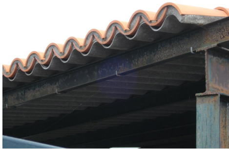
afb. 06.2.1 - 11 Tuiles canal tweelagig op golfplaat
