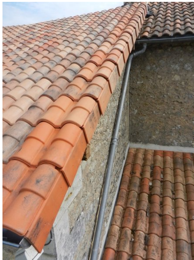
afb.06.2.1 - 12a Drie daken met verschillende modellen pseudocanal, links een model 2x2, en met randpannen
